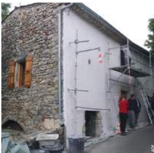
La façade délabrée d'une maison de Limans est réparée avec un enduit isolant à base de chaux, d'argile et de liège.
