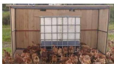
**Structure légère :** une ossature en petits tubes carrés, pour un bâtiment déplaçable aisément avec un petit tracteur ou une camionnette
